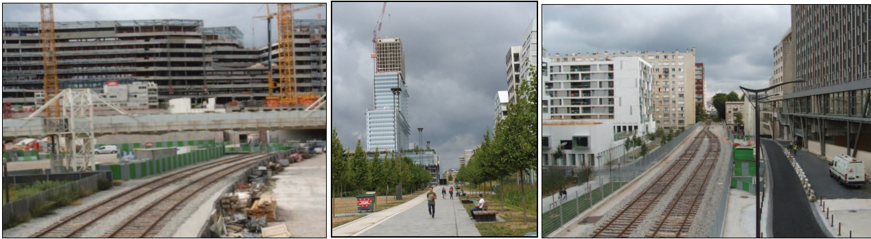
Abb. 11-13: Die Baustelle des Stadtteiles ZAC Clichy-Batignolles im Sommer 2016 mit der wiedererrichteten Güterbahntrasse
